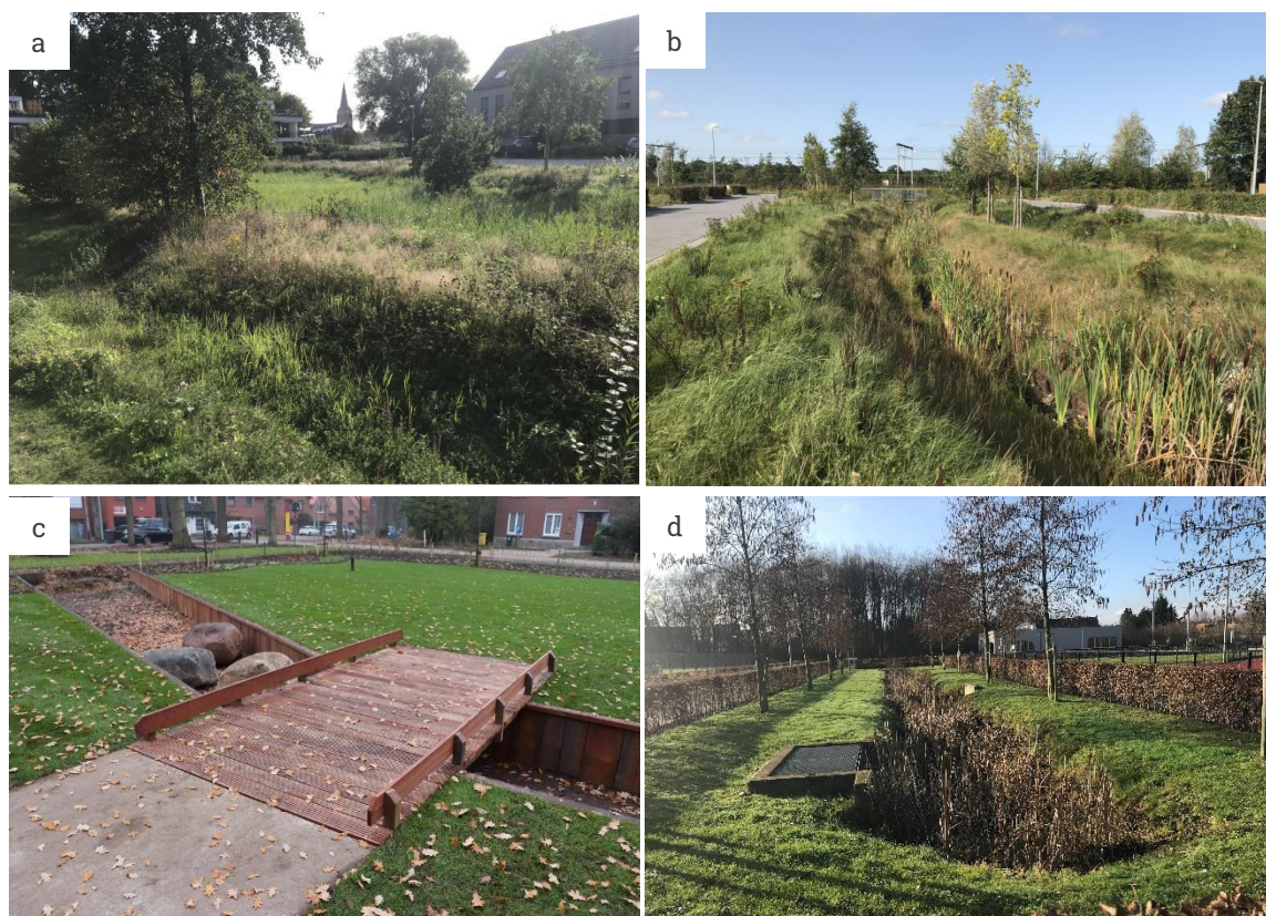
Figuur 16: Buffer- en infiltratievoorzieningen aan Groenhof (a), Krenkhoek (b), Heidestatieplein (c) en het sportpark (d).
