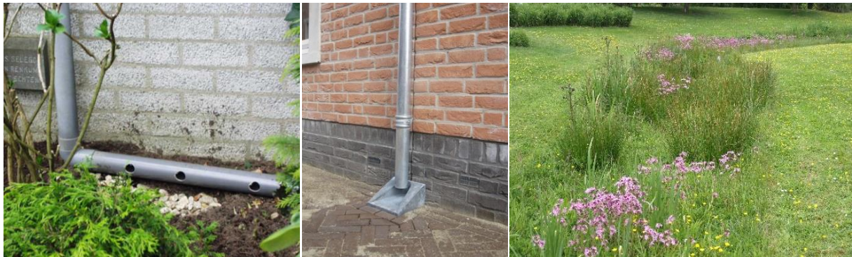
Figuur 4: Voorbeelden van bovengrondse infiltratievoorzieningen.
