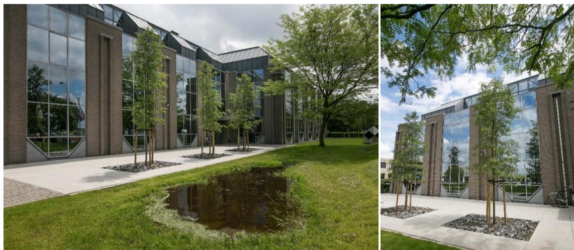
Figuur 3: Toepassing van het Stockholm principe aan het Aquafin hoofdkantoor te Aartselaar.
