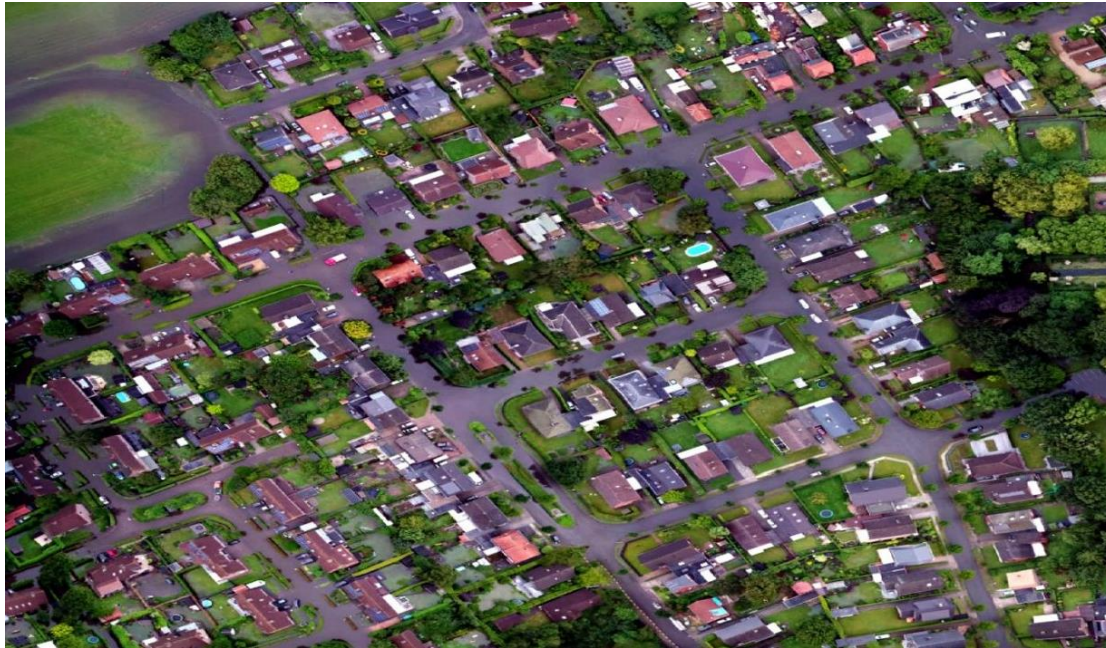
Figuur 19: Luchtfoto van de wateroverlast in de wijk Cassenboom. Merk op dat de groenzones op straat en de sportterreinen niet voldoende worden benut voor het opvangen van regenwater (bron: VMM).
