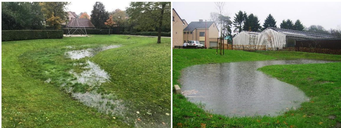
Figuur 11: Wadi ter hoogte van het speelpleintje langs de Victorine Van Mechelenlaan.
