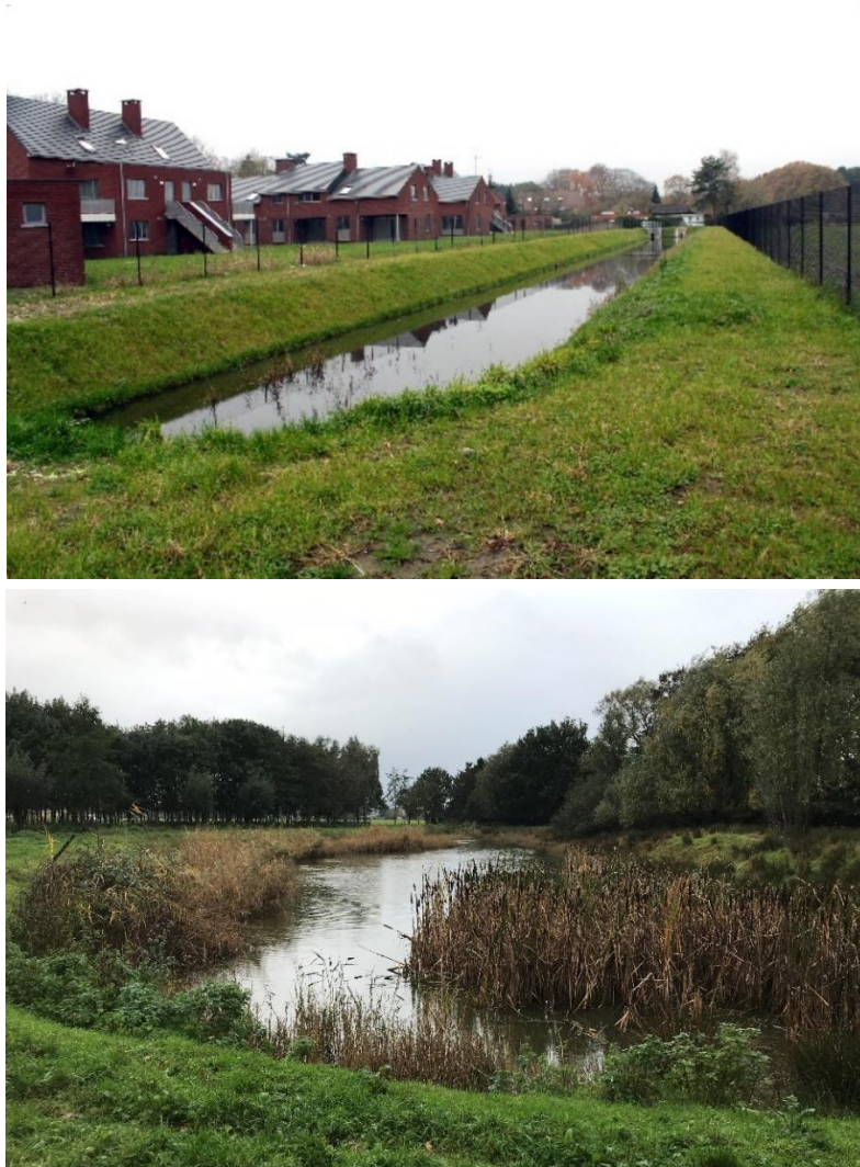
Figuur 14 : Open bufferbekken aan de Kijkuitstraat (boven) en Kruisbos (onder).
